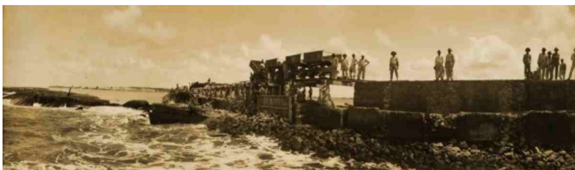
Francisco du Bocage (autor). Construção do Dique do Nogueira. 1910. Coleção Benício Dias. Fundação Joaquim Nabuco.
